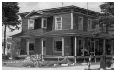
↑ Maison à loggia. Cookshire-Eaton, secteur Cookshire
