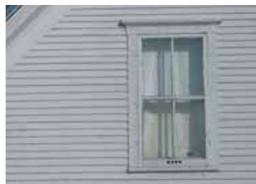
↑ Chambranle autour d'une fenêtre sur un revêtement de planche à clin. Cookshire-Eaton, secteur Sawyerville.
