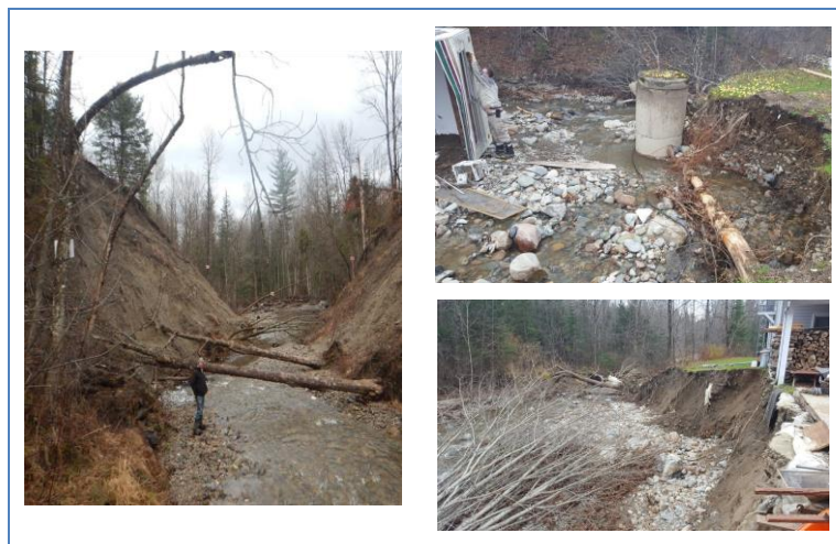
Photo 3 : Conséquence d'une crue, ruisseau Big Hollow
